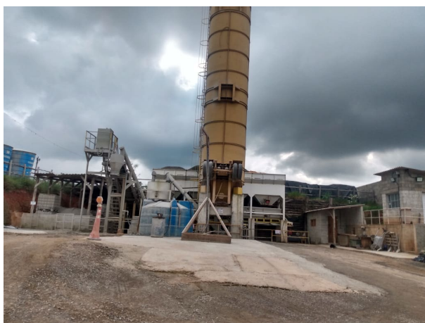
Foto 3: Manutenção Mecânica de apoio no canteiro operacional (27/04/2023)
