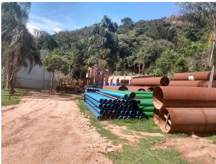
Foto 7-Montagem de equipamentos e sistemas- rodas de dragagem. 02/2023
