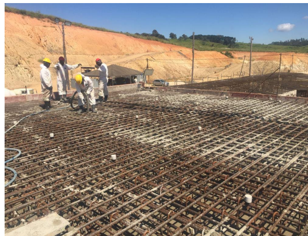
Foto 12: Vista da galeria de desvio. (17/04/2023)
