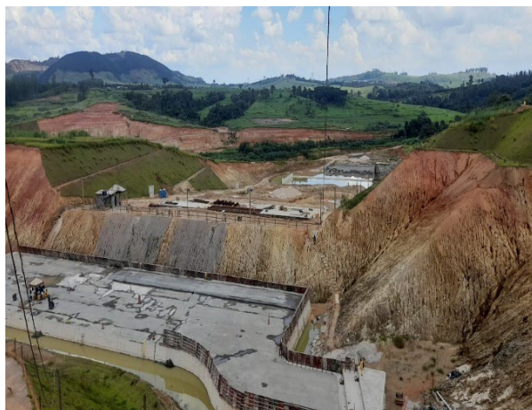
Foto 9: Vista da galeria de desvio. (29/03/2023)
