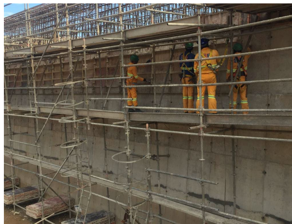
Foto 10: Vista da galeria de desvio. (30/03/2023)
