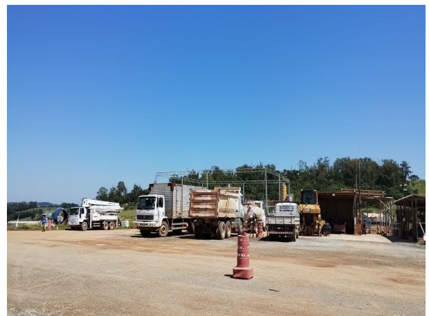
Foto 2: Manutenção Mecânica de apoio no canteiro operacional (23/03/2023)
